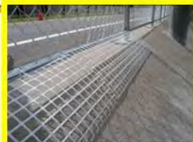
ワンウェイゲート ▽ 道路上にヤマネコが侵入した際、安全に柵外へ脱出でき、道路脇から道路内への侵入を防止するゲート。
