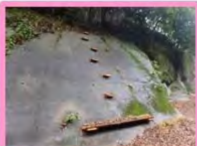
ネコ階段 ▲ 道路法面を小動物が登れるようにしたもの。
