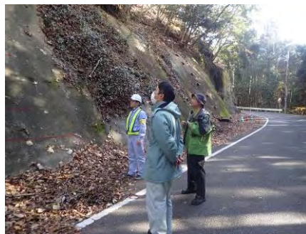
2 か所目の設置設計現地打合せ
