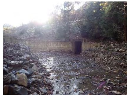
カルバート清掃後
