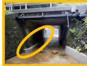
ネコ走り ○ 道路下のカルバートの中に段差を設置し、水かさが上がっても野生動物が通過できる。
