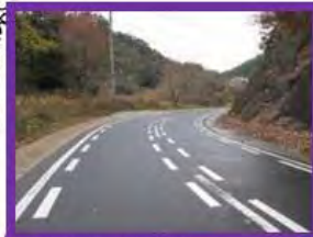
ドットライン塗装 ▽ 車線を狭く見せることにより、ドライバーによる無意識の減速を促す。
