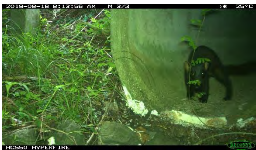
野生動物用集水樹設置後のカルバート（1-2集水樹）を利用するツシマテン（R1. 8. 18）
