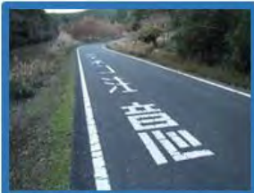
路面標示 ▽ 路面に表示することによってドライバーに対して注意を促す。
