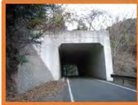
オーバーパス □ 車両とヤマネコの通路を立体交差にしたもの。
