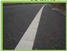
リフ付き区画線 □ 車が走るとガタガタ音が出る路側線。路肩にいる野生動物への注意喚起につながる。
