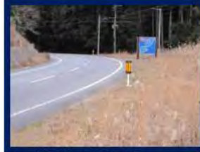
野生動物用反射板 ◇ 車のヘッドライトの反射により道路脇にいるヤマネコの道路接近を防止する。
