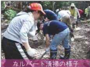
カルバート清掃の様子
