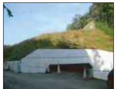
ヤマネコがトンネルの上を渡ります
