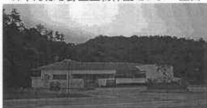
「昨日まで台風災害で土砂が駐車場に流れ込み悲惨な状況でした。」
