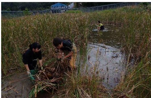
ガマの撤去作業
