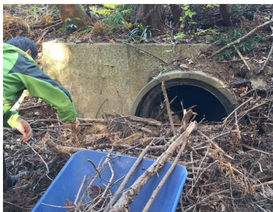
閉鎖したカルバート
