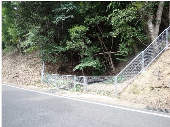
設置された侵入防止柵（ネットフェンス）
