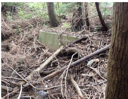
閉鎖したカルバート
