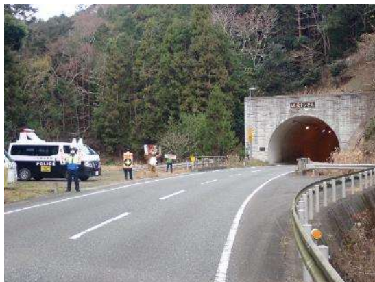
トンネル内ライト点灯推進活動の実施状況
