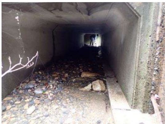
清掃前のカルバートの状況
