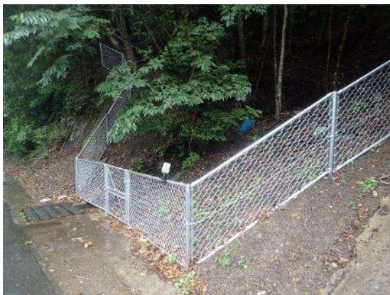
道路横断用トンネルと侵入防止策
